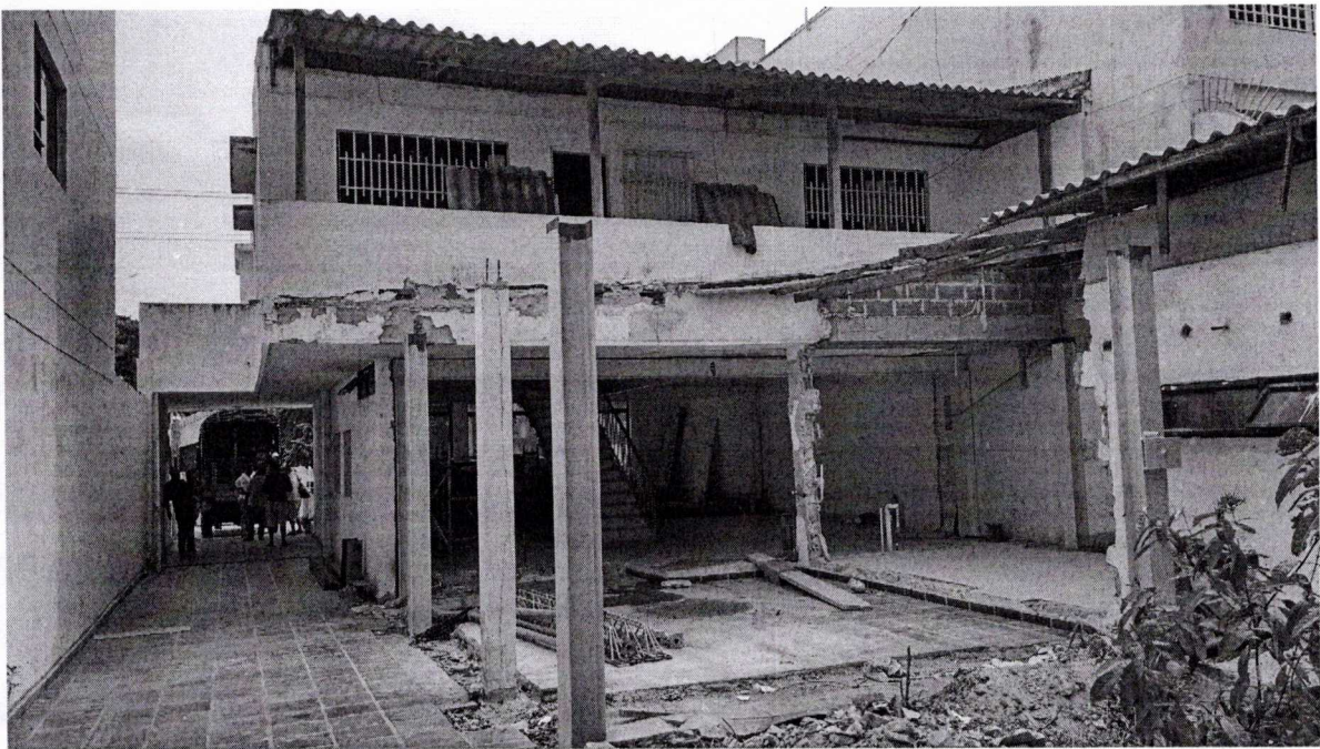
SE OBSERVA EL REFORZAMIENTO ESTRUCTURAL CON PERFILES METALICOS IPE
