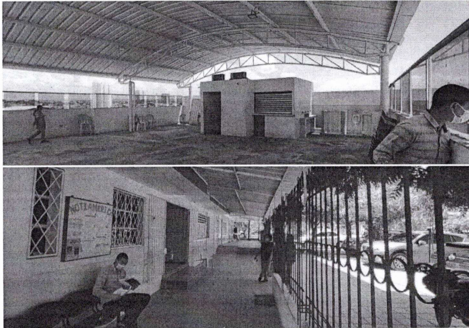
Figura 7. Altillo con cubierta en lámina delgada soportada en estructura metálica y zona de antejardín de los predios en mención (Barrio Nuevo Bosque). Nótese antejardín techado en cubierta metálica y cerramiento perimetral en muro y reja alta. Fuente: Dirección de Control Urbano - DCU, 2022.
