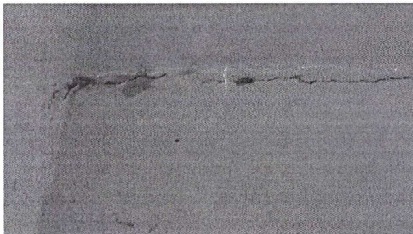
Foto No.1-2-3 Vista Muros Agrietados
