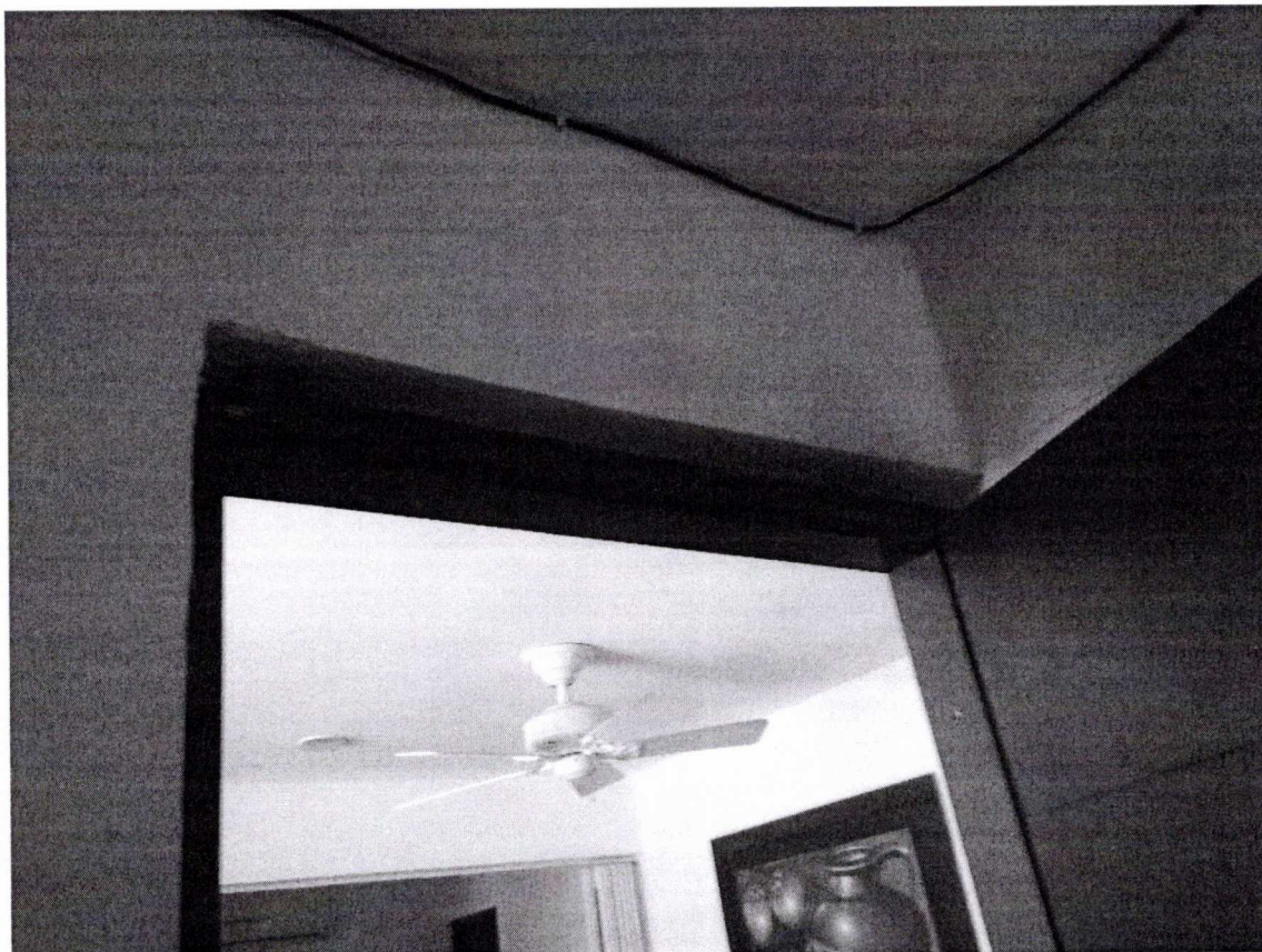
DESPRENDIMIENTO EN MARCOS Y DESNIVEL DE PUERTAS
