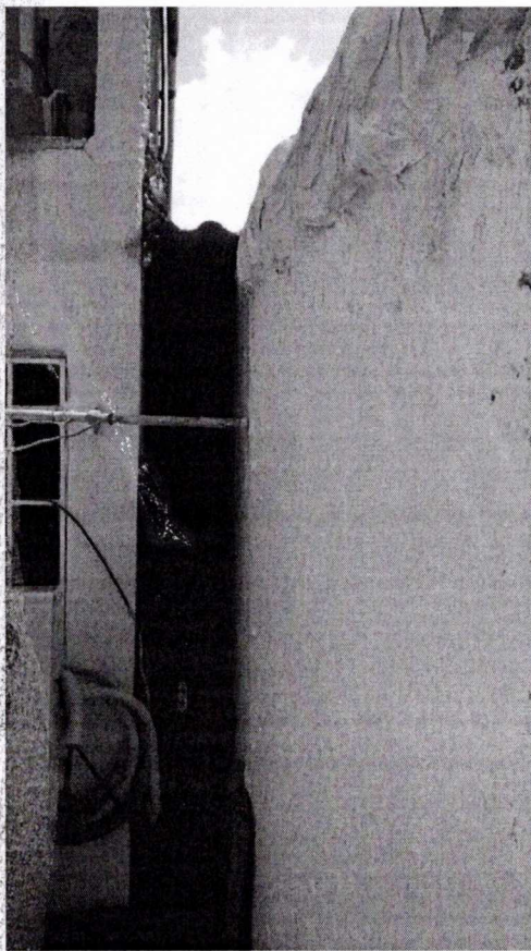
CAMARA DE AIRE EXISTENTE ENTRE LAS DOS VIVIENDAS
