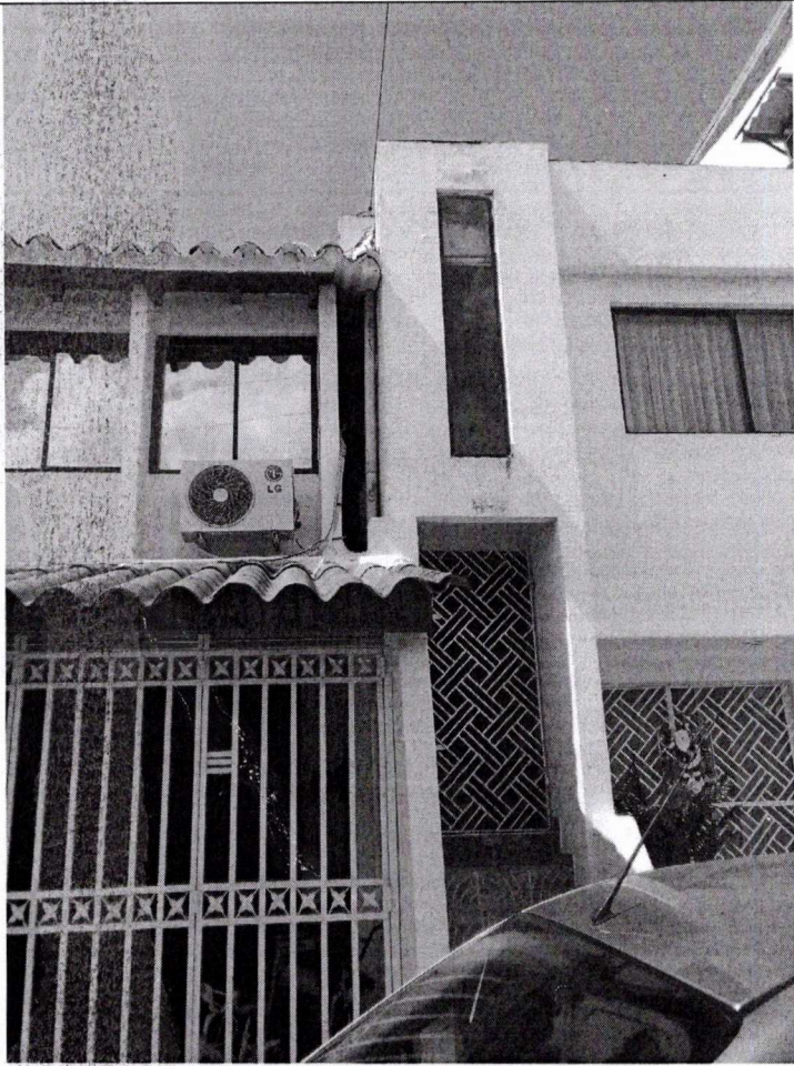
CAMARA DE AIRE EXISTENTE ENTRE LAS DOS VIVIENDAS
