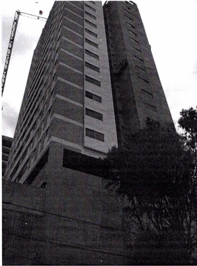
Foto No.2 Fachada Edificio Menta
