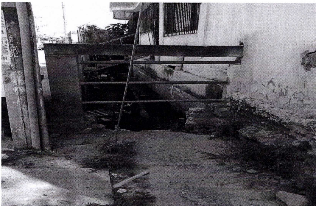
FOTOGRAFIA DEL CANAL DE AGUAS LLUVIAS, CERRAMIENTO CON COLUMNAS EN CONCRETO Y VARILLAS METALICAS.
