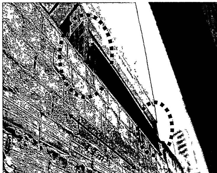
Figura 6. Vista de la Construcción desde el predio del quejoso, en la se puede visualizar que una parte de la construcción fue adosada las columnas al muro divisorio de ambos predios. Fuente: DCU, 2022.
