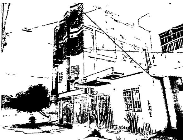
Podemos apreciar los cuatro pisos de la edificación, el primero y segundo piso están habitados, el tercero y cuarto están en obra negra, la obra se encuentra paralizada, se puede apreciar la estructura la cual se debería pedir un concepto a un Ingeniero calculista, para ver si cumple con las normas.
