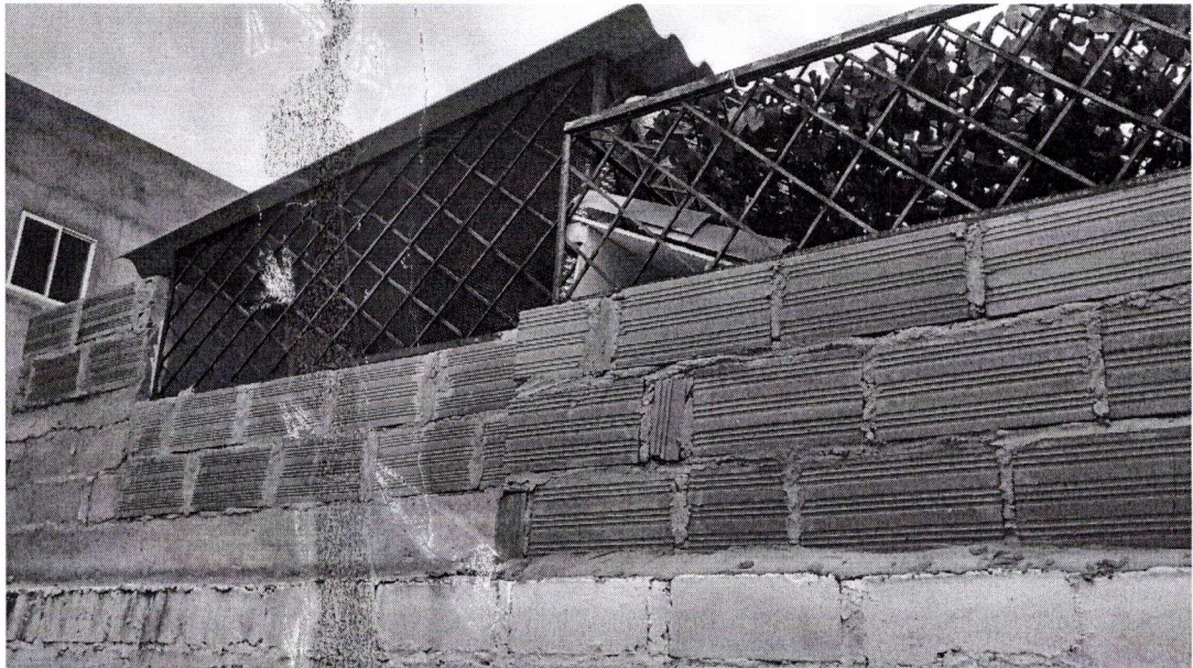
Área de patio donde se encuentra una construcción con techo en láminas de eternit, con dos hiladas en ladrillo rojo y estructura metálica
