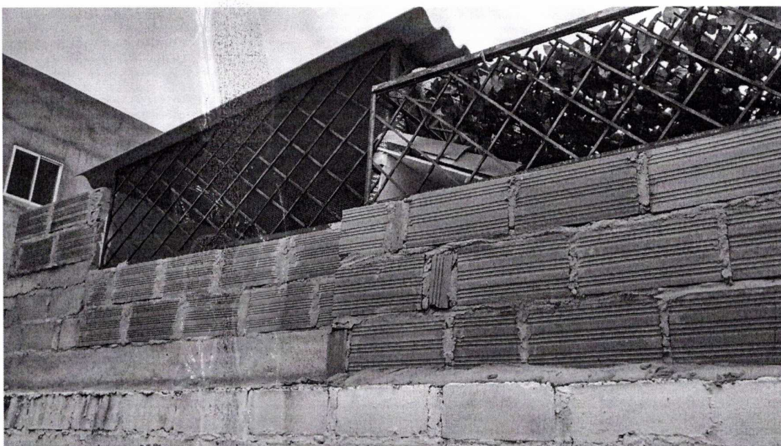
IMAGEN No. 5 CONSTRUCCIÓN CON TECHO EN LÁMINAS DE ETERNIT, DOS HILADAS DE LADRILLO ROJO Y ESTRUCTURA METÁLICA
