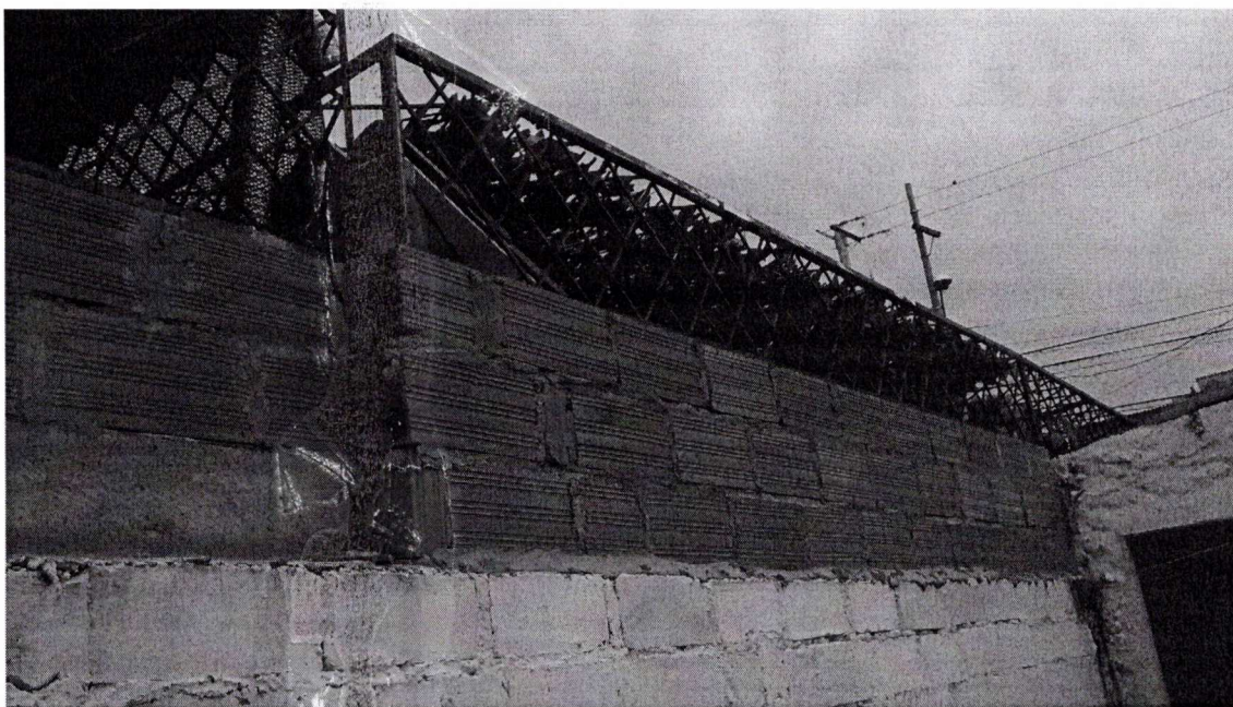
IMAGEN No. 4 SE OBSERVA LA INSTALACIÓN DE LA ESTRUCTURA METALICA Y LAS 3 HILADAS DE BLOCK ROJO
