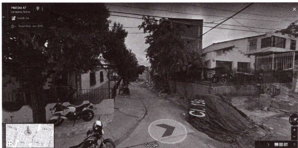
En la gráfica se observa el edificio en construcción año 2016
