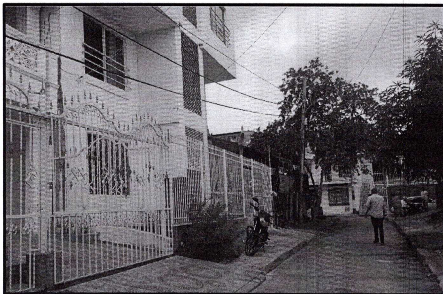
VISTA FACHADA PRIMER Y SEGUNDO NIVEL
