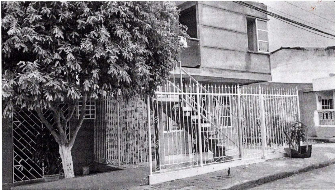
ESCALERA UBICADA EN ÁREA DE ANTEJARDIN DE LA VIVIENDA, MANZANA E LOTE 13, URBANIZACION EMMANUEL
