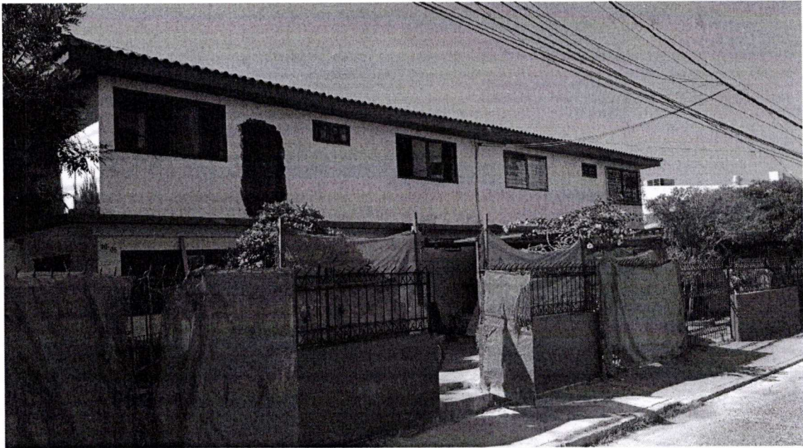
FACHADA DE LA CASA EN CONTRUCCION EN LA MODALIDAD DE ADECUACION.
