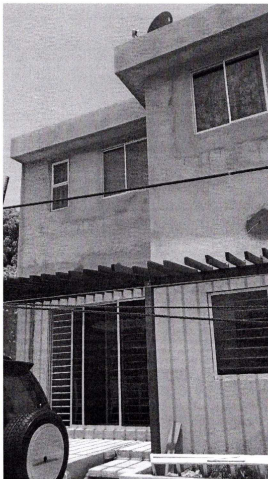
-VIVIENDA BIFAMILIAR DE 2 (DOS) PISOS UBICADA EN LA PARTE POSTERIOR DEL PREDIO CON REFERENCIA CATASTRAL No. 01-02-0225-0024-000000, MOTIVO DE LA SOLICITUD DEL RECONOCIMIENTO DE LA EXISTENCIA DE UNA CONSTRUCCION
