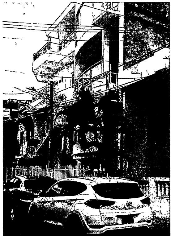
Registro fotográfico de Fachada durante fase de reconocimiento del predio. Fuente: Departamento Administrativo de Control Urbano, 2018.
