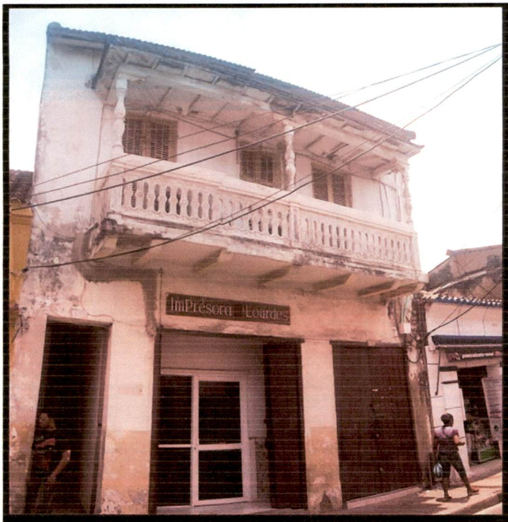
FOTOGRAFIA DEL ASPECTO ACTUAL DE LA FACHADA EDIFICIO IMPRESORA LOURDES
