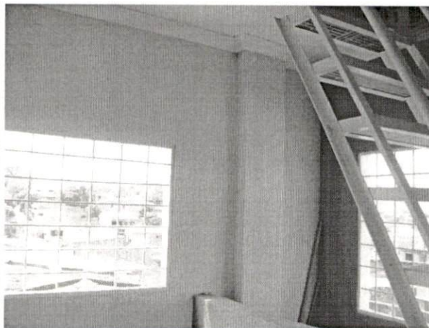
Vista de las columnas nivel 2
