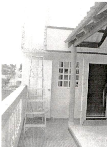
Figura 2. Pared lateral izquierda de la edificación acceso a cubierta mirador
