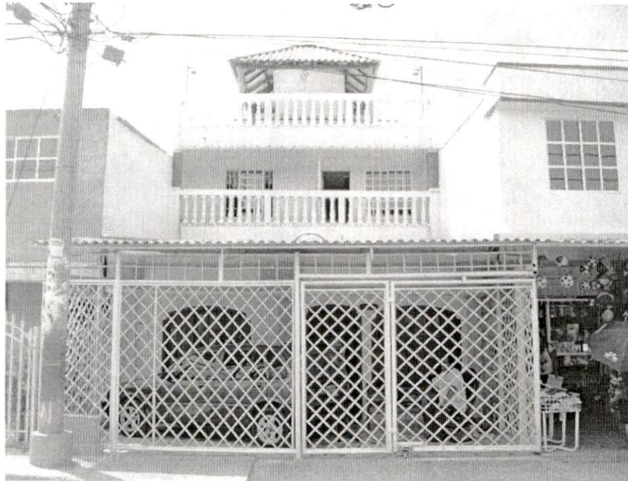
Figura 1. Facha Principal, vista anterior del edificio
