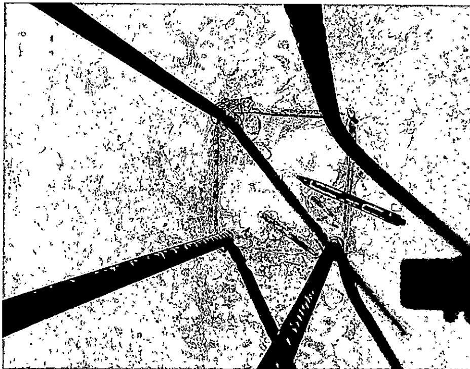
Figura 27. Refuerzo transversal de columna sin recubrimiento
