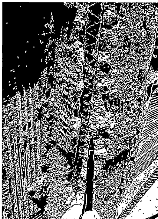
Figura 28. Refuerzo longitudinal de columna sin recubrimiento.
