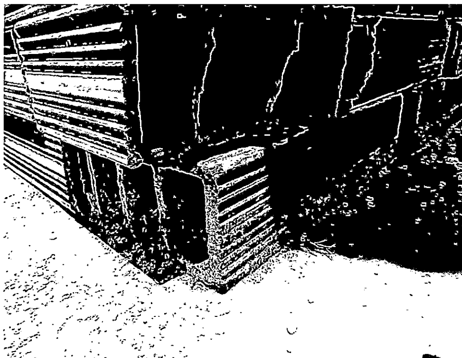
Figura 26. Muro en mampostería sin mortero de pega en la base.
