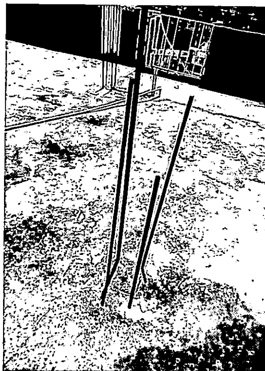
Figura 29. Refuerzo longitudinal de columnas expuesto
