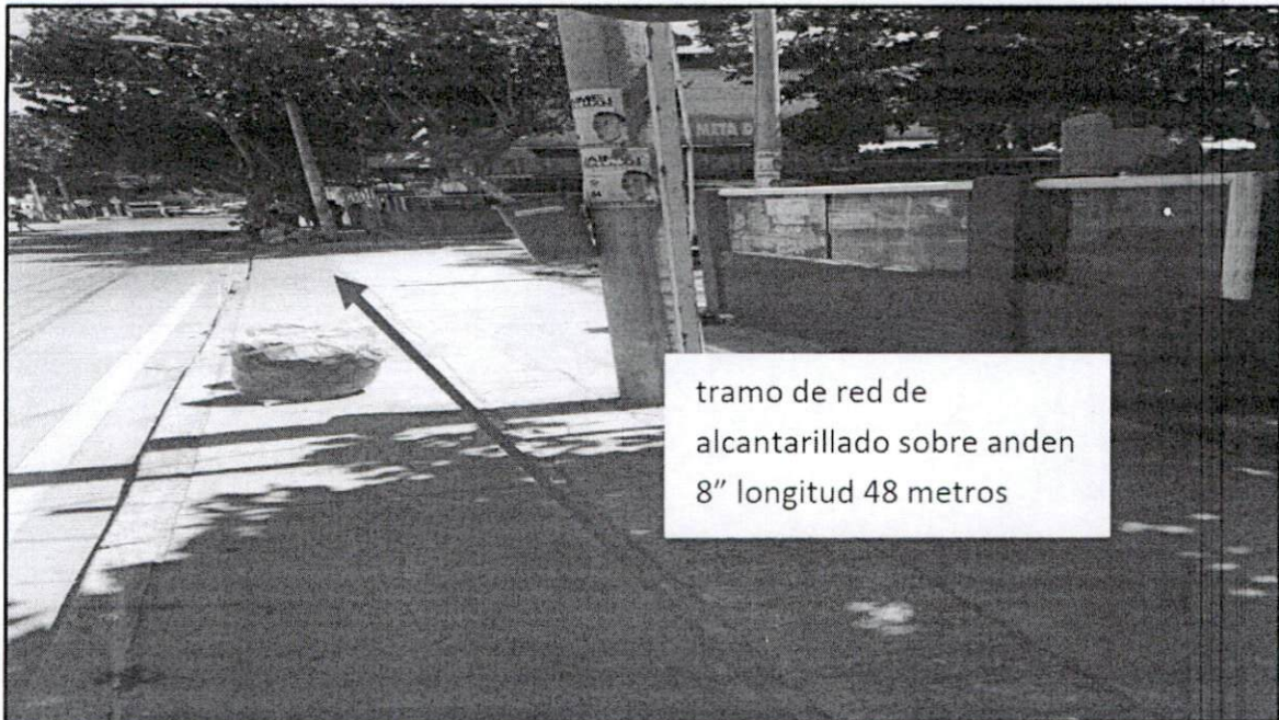
Tramo de red de alcantarillado barrio creso sobre anden calle 70 entre carrera 8 y Cra 9
