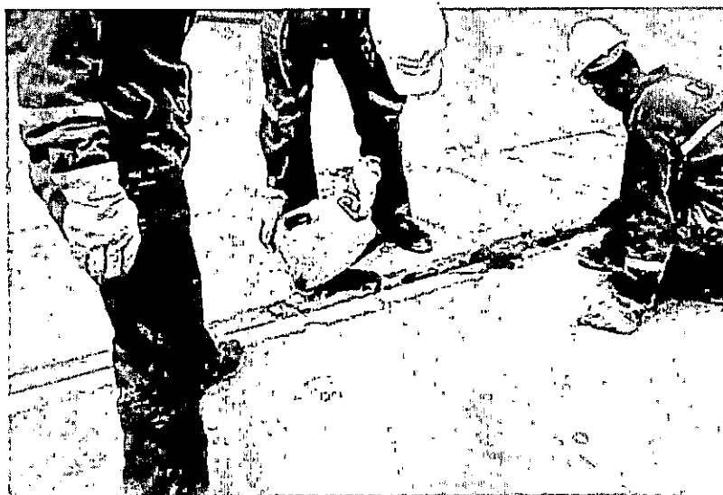
Recubrimiento con Mortero Seco
