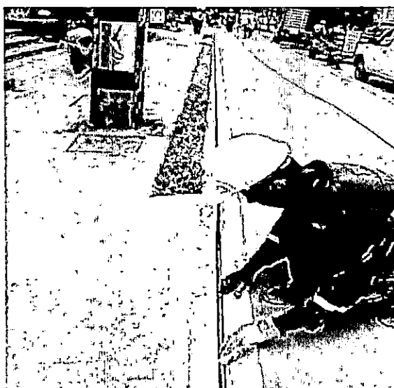
Instalación de ducto
