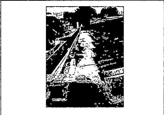
Fotografía 16: Tubería atravesando el muro de antepecho.
