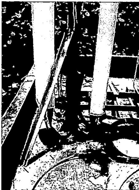
Figura 22 Anclaje de antena a placa de cubierta. No se cumple con la longitud de anclaje de los pernos.
