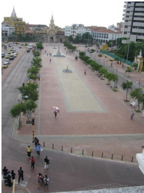
Camellón peatonal al frente torre del reloj
