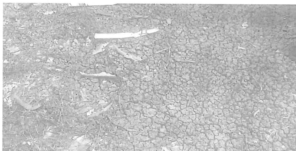
Presencia de arcillas expansivas y fluidos grisáceos
