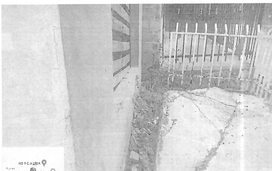
Levantamiento de plantilla de piso en terraza de vivienda Calle Las Flores
